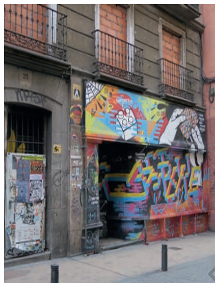
Fig. 44 Entrée scellée du Patio Maravillas Calle del Pez
