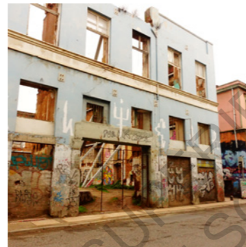
BÂTIMENT DU BARRIO PUERTO EN ATTENTE DE RÉNOVATION Photographie de l'auteure - Juin 2017
