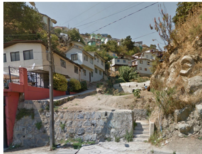
SITUATION PRÉ-INCENDIE CALLE ALESSANDRI Février 2012 - Google maps
