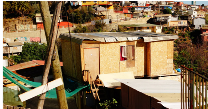
MÉDIAGUA - CERRO LAS CAÑAS Mai 2017 - Photographie de l'auteur
