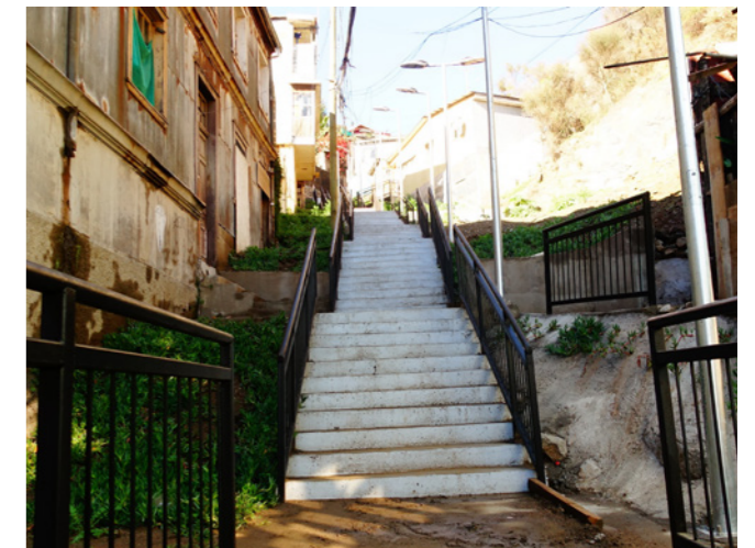
CERRO LAS CAÑAS - AMÉLIORATION DES ACCÈS - QUEBRADA POCURO Mai 2017 - Photographie de l'auteure
