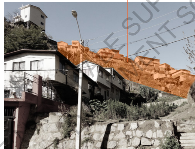
SITUATION POST-INCENDIE : RECONSTRUCTION AU MÊME ENDROIT CALLE ALESSANDRI Mai 2017 - Photographie de l'auteure
