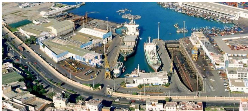
Figure 17 : Le chantier Naval.
