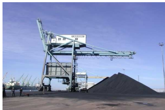
Figure 15 : Le terminal minéralier de Marsa Maroc.
