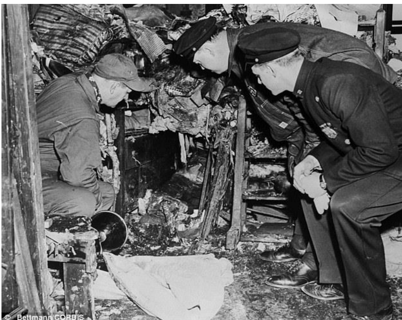
Image 3 : photo du tunnel creusé au milieu des ordures par les frères Collyer. (27)
