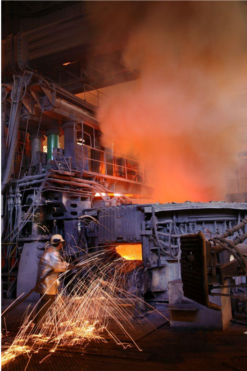
Figure 16: Opération de réparation du four à l'aide d'un béton projeté au travers de la porte du four
