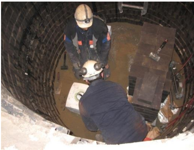
Figure 25 et 26: Différentes étapes de la réfection des poches de coulée
