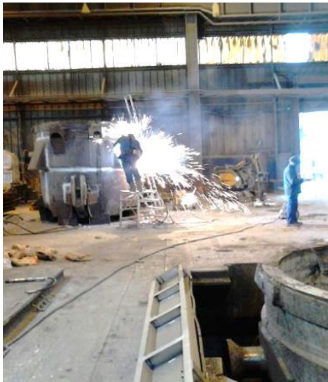
Figure 27: Découpe à l'arc air de l'armature d'une poche d'acier
