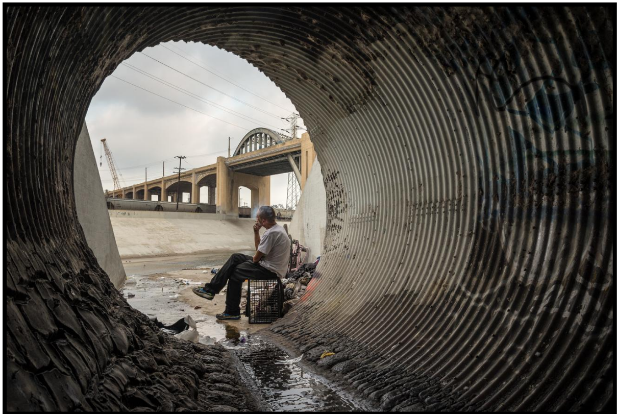
Un sans-abri vivant dans les tuyaux d'évacuation en banlieue de Los Angeles
