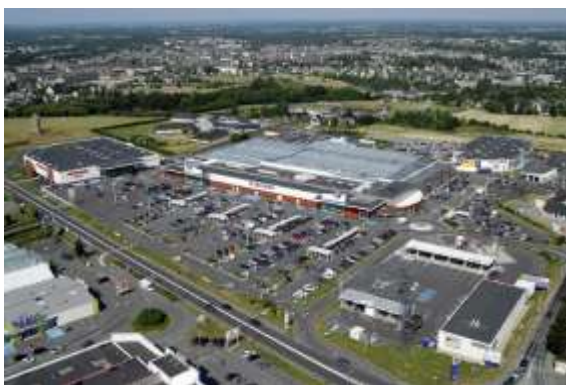
Photo n°1 : Une zone commerciale périphérique
