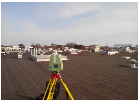
Figure 3 : Leica P20 pour relevé 3D de toiture de centre commercial (Source : Prise de vue personnelle - 2015).
