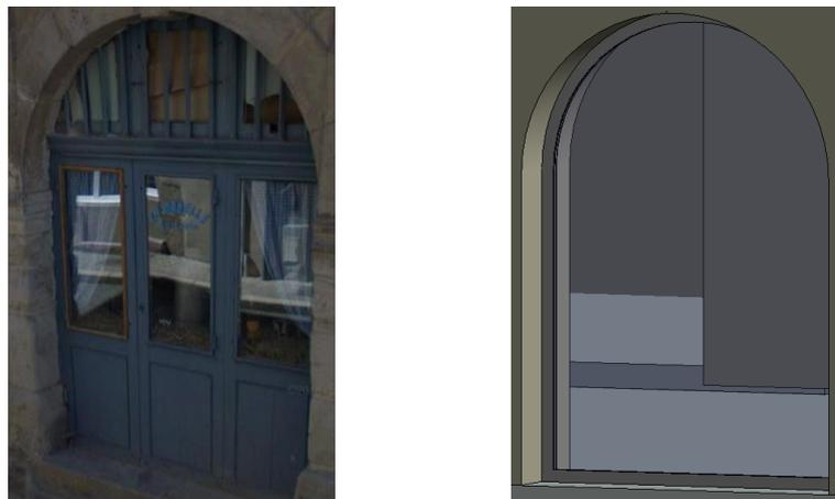
**Figure 14 - Comparaison entre la menuiserie en place et l'objet utilisé par *Snapkin***
