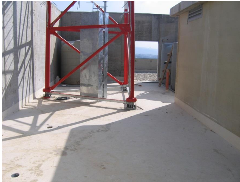
Figure 8: Fixation directe du pylône à la dalle
