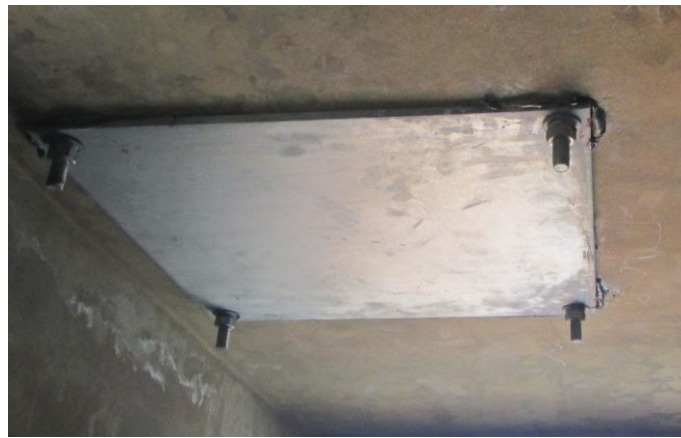
Figure 15: Fixation par une contre plaque
