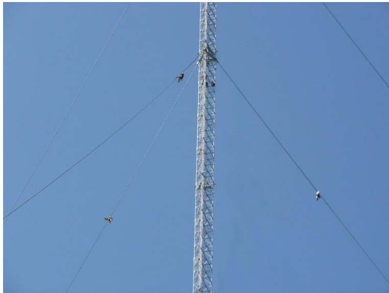
Figure 2: Les pylônes à haubans
