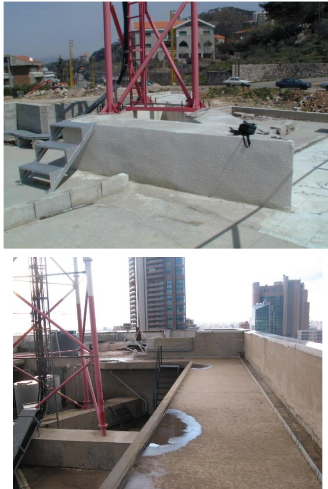
Figure 10: Fixation à l'intermédiaire des poutres en bétons
