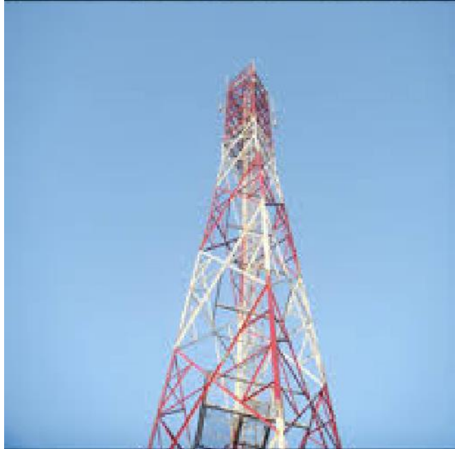
Figure 3: Les pylônes à quatre pieds
