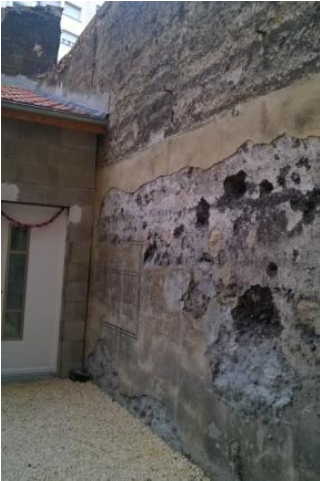
Figure 7 : Photo du mur de la cour du CADA (source : R. Janina, 2017)
