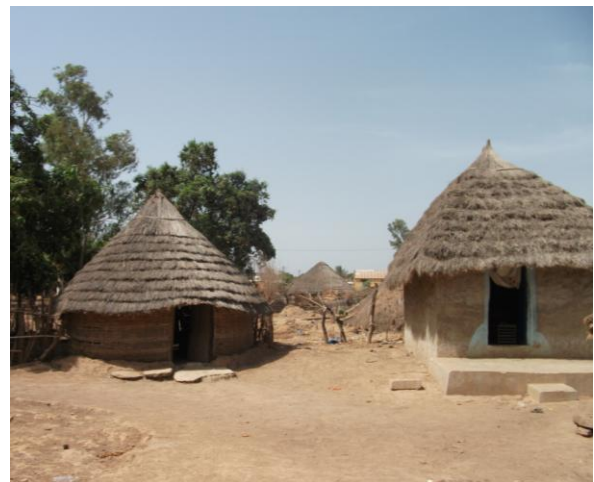
Photo 2 Diversité des types de bâti : bâtiment en dur et tôle versus cases en crintin, banco et chaume (Kédougou)
