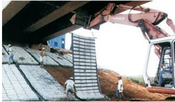
Figura 20: Protección de estribo de puente
