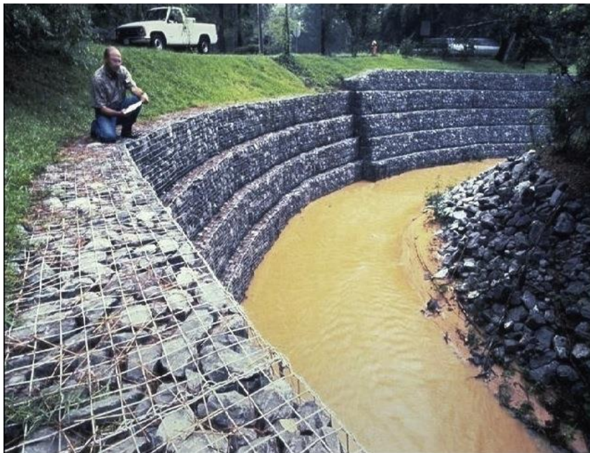
Figura 12: Gaviones tipo caja ( http://es.wikipedia.org/wiki/Gavi%C3%B3n#mediaviewer/File:Gabion.jpg )
