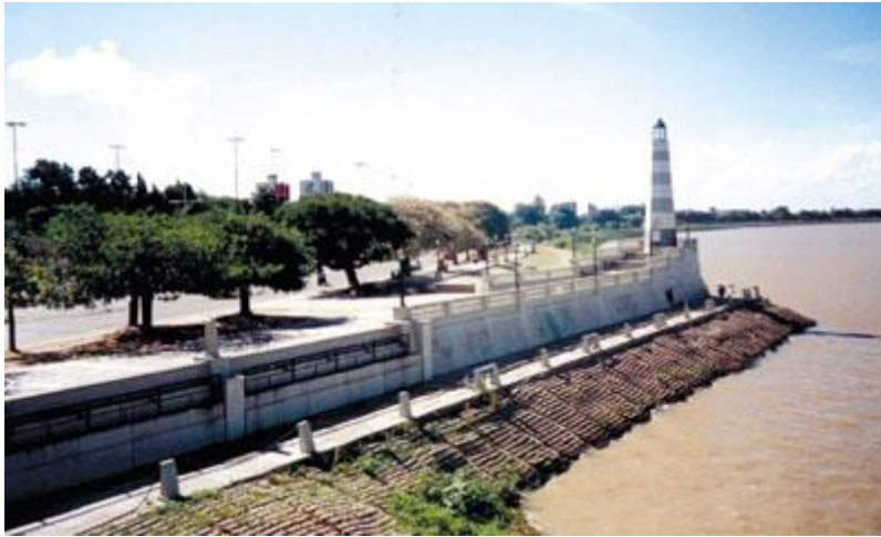
Figura 18: Revestimiento constituido por bloques de hormigón adherido a geotextil
