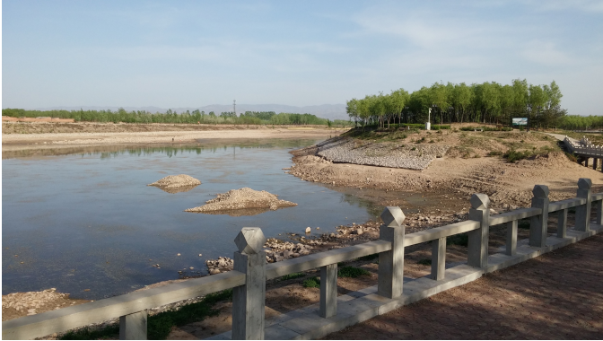
Liujiapu, début du Parc, déjà construit depuis 2012
