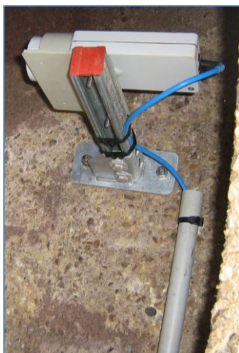
Figure 5: Seuil en aval de la surverse du SR Plateau (à gauche) et sonde piézométrique du SR de la Chesnaie (à droite). (Source : Service exploitation de la Régie Eau et Assainissement ALM)
