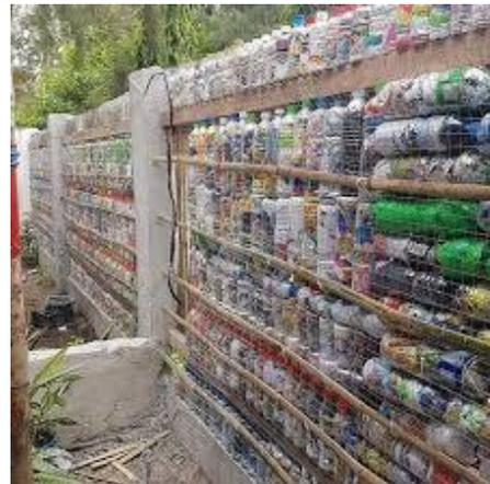
Figure 21 : Mur en écobrique. Source : France24.com
