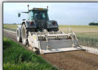
Figures 13 - Chemin d'accès avant et après renforcement
