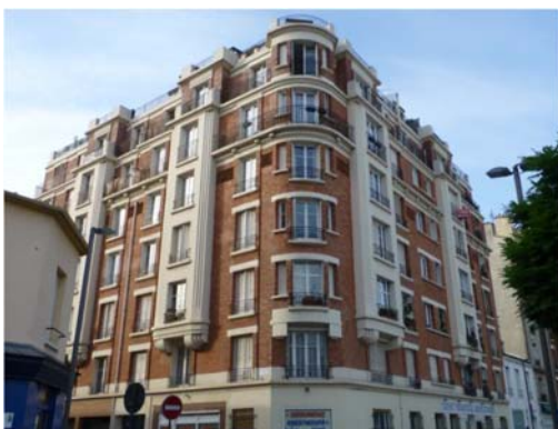
Figure 10 : Copropriété rue Jean à Saint Ouen (Projet COMPACT)
