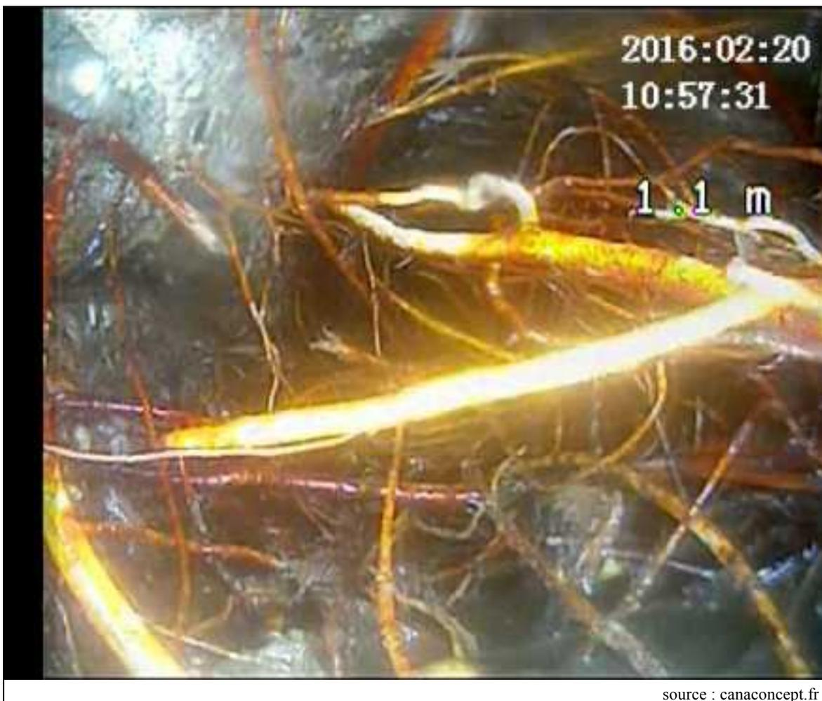
*Figure 7 : Inspection télévisée (ITV) montrant une canalisation d'eaux usées envahie par des racines*
