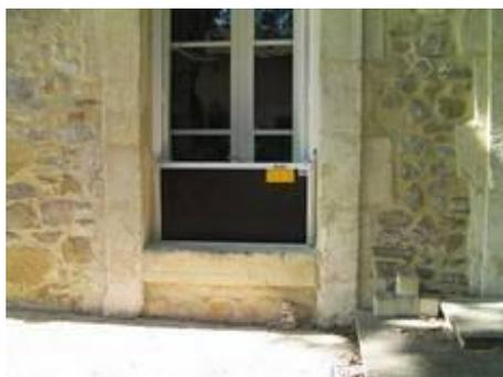
*Panneau anti-inondation fixé sur une fenêtre (Colurex)*
