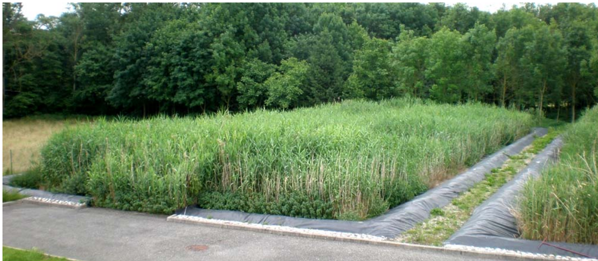
Figure 25 : Photo du lit à vidanger (lit n°1 « coté rivière »)
