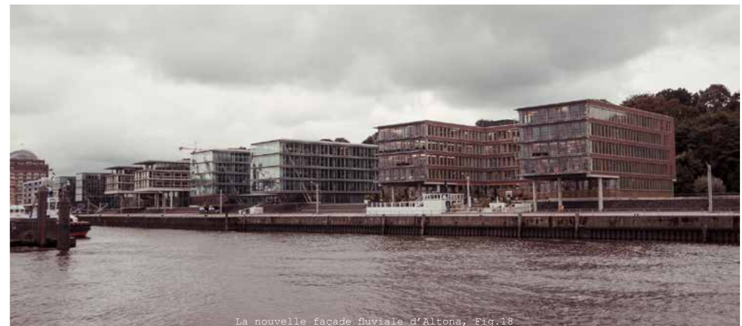
La nouvelle façade fluviale d'Altona, Fig.18
