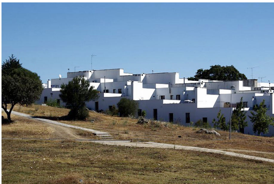
Fig. 27 : projet Quinta de Malagueira - Arch. : Alvaro Siza Source : Alvaro Siza [ http://www.archdaily.mx/ ]
