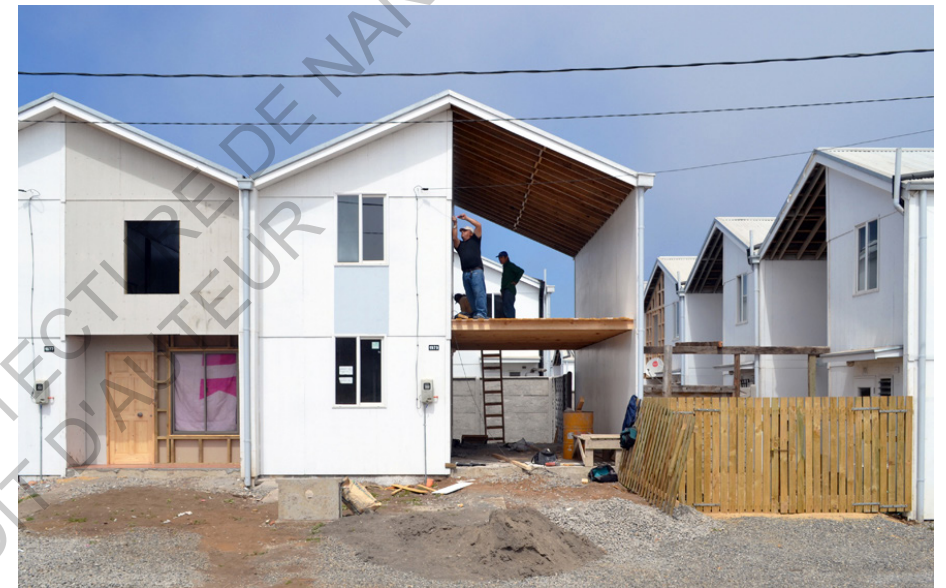
Fig. 21 : Construction de la seconde moitié d'un logement par des habitants, à la Villa Verde, à Constitución - Arch : Studio Elemental Source : Studio Elemental [www.elementalchile.cl/]
