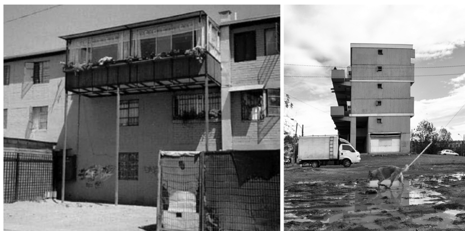
Fig. 12 : Extension très précaire réalisée au dernier niveau d'un multistory Building . Source : Alvaro Arancibia [http://projectivecities.aaschool.ac.uk/]
