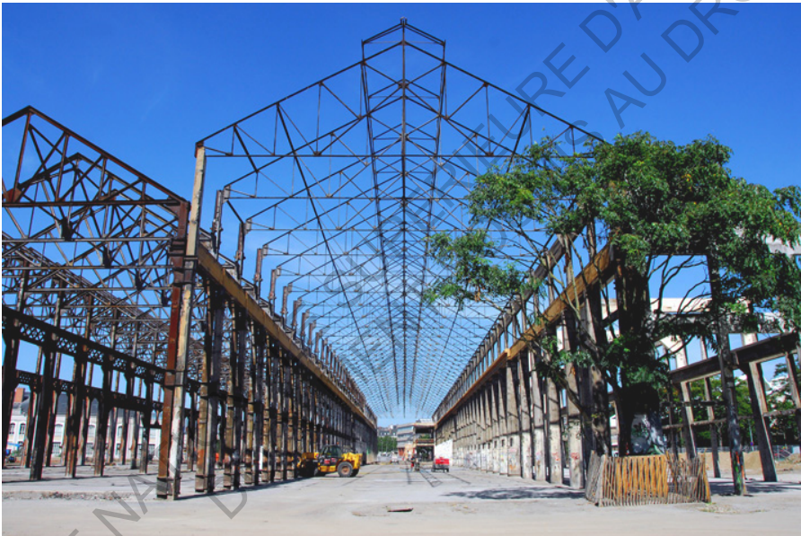
Fig. 27 - Halles pendant la réhabilitation http://www.iledenantes.com
