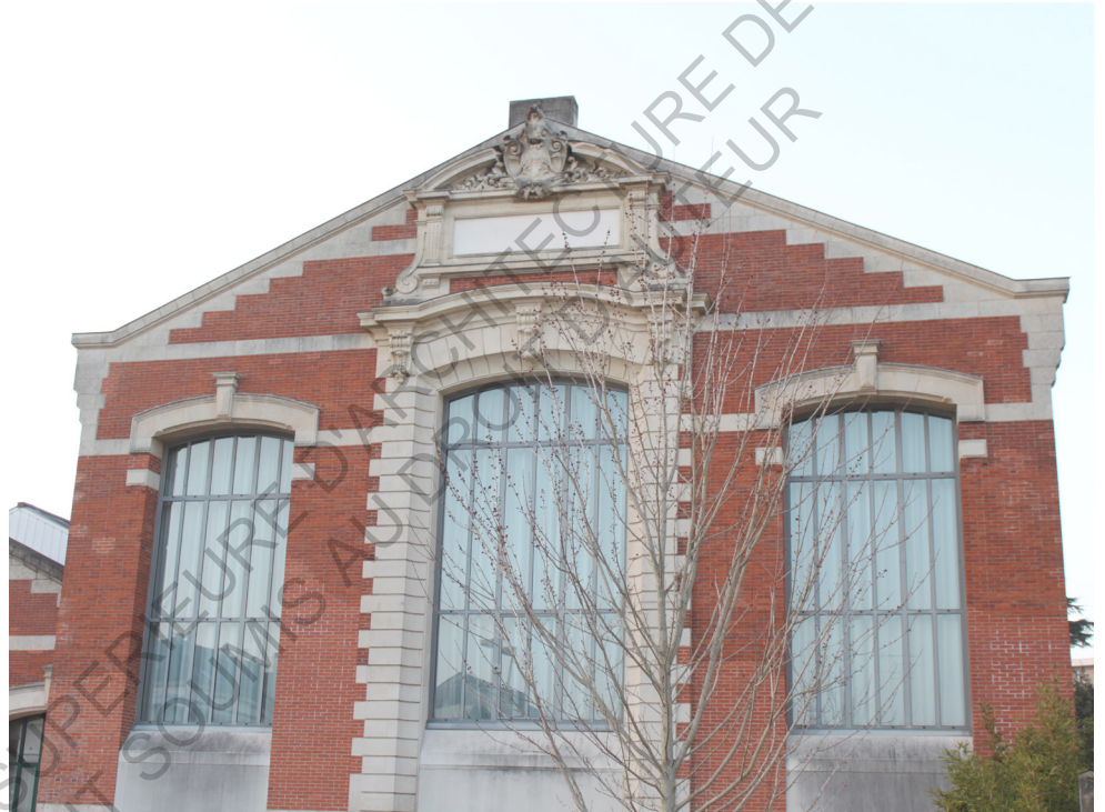
Fig. 25 - Façade du grande halle électrique de Lamoricière Photo © Dalila Delgadillo
