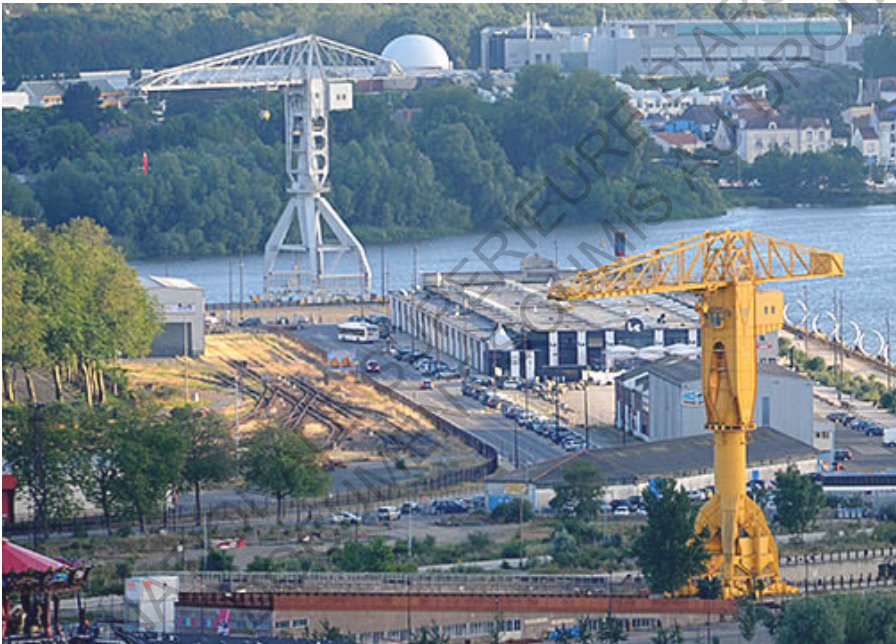
Fig. 6 - Les grues Titan de Nantes Photo www.nantes.fr
