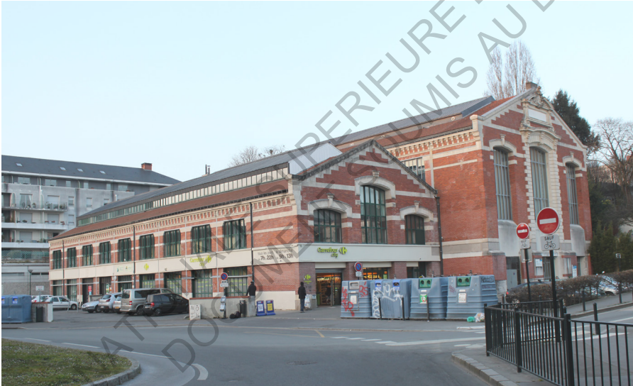
Fig. 24 - Deux halles, ancienne usine électrique de Lamoricière Photo © Dalila Delgadillo
