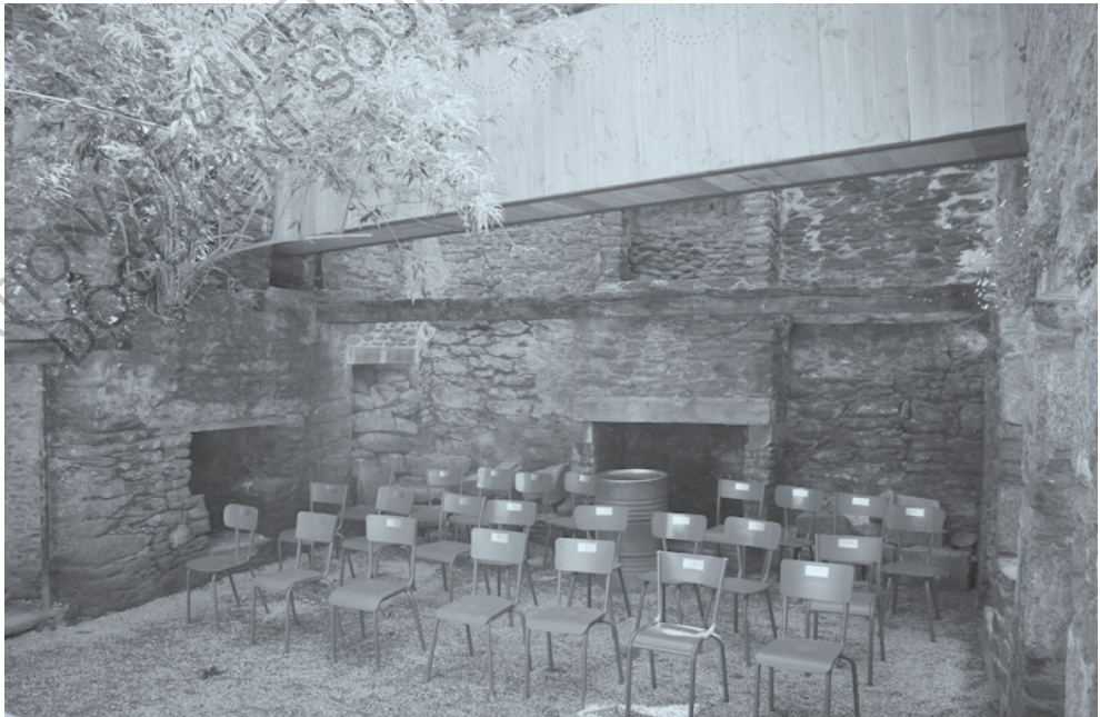
Situation de la rue de Saint Malo. Le projet du collectif ETC avec sa passerelle passant au dessus de la salle de théâtre et connectant la rue Saint Malo et la promenade haute.
