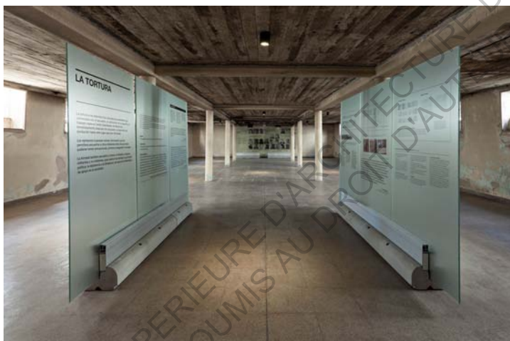
Fig D.5: Vue du Sotano transformé en musée. Les panneaux d'explication prennent place le long des anciennes parois rajoutées par les militaires. On remarque qu'elles ne sont en contact avec le bâti que par leur socle, celui décrit ci-contre par Hernan Bisman. http://www.barquitectura.com.ar/?p=2083
