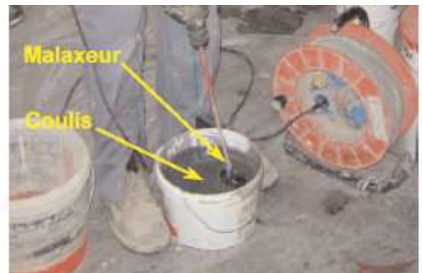
Figure IV.8. Début du mélange résine et durcisseur (photo Freyssinet).
