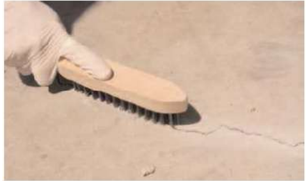
Figure IV.18. Nettoyage d'une fissure par une brosse métallique.
