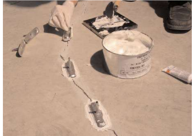
Figure IV.7. fissure en cours de cachetage (photo Freyssinet).
