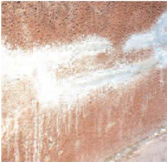
Figure IV.4. Calfeutrement de fissures à l'aide d'un mortier à base de liants hydrauliques.
