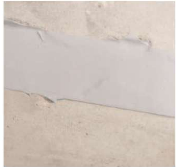
Figure IV.5. Calfeutrement d'une fissure à l'aide d'un mastic à base de liants organiques.
