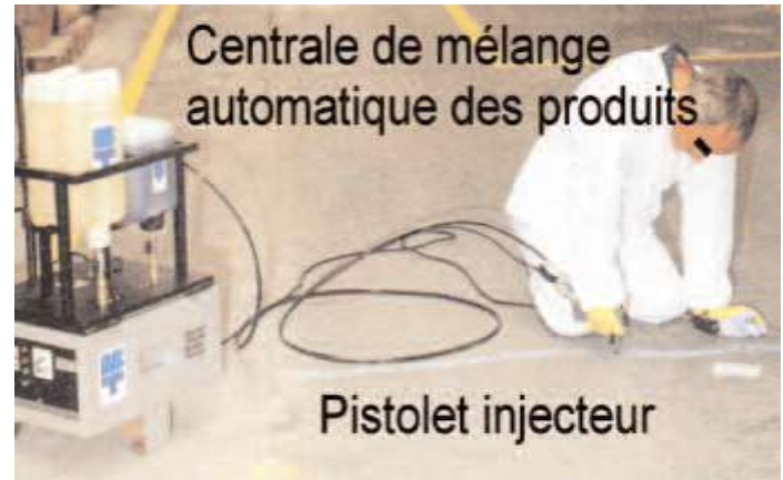
Figure IV.10. Utilisation d'un pistolet injecteur (d'après un document du procédé Concrecive MBT).
