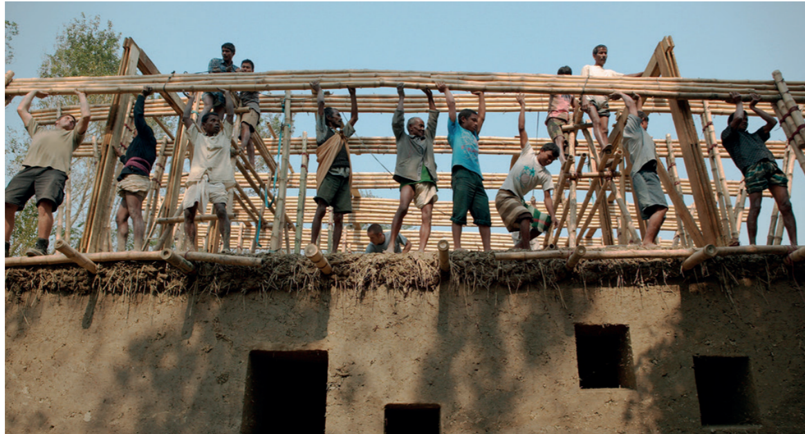
Chantier de l'école METI à Rudrapur Bengladesh. Architecte Anna Heringer
