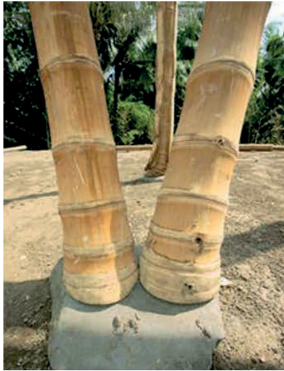
Pied de Colonne par FT Althoff pour une usine de bijouterie à Ubud en Indonésie (Minke, 2000)
