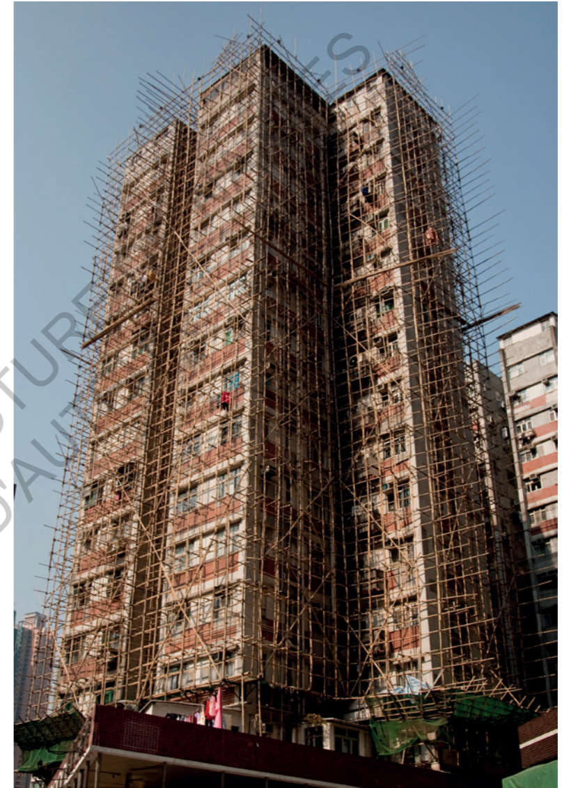
Echafaudage à Hong Kong, Chine
