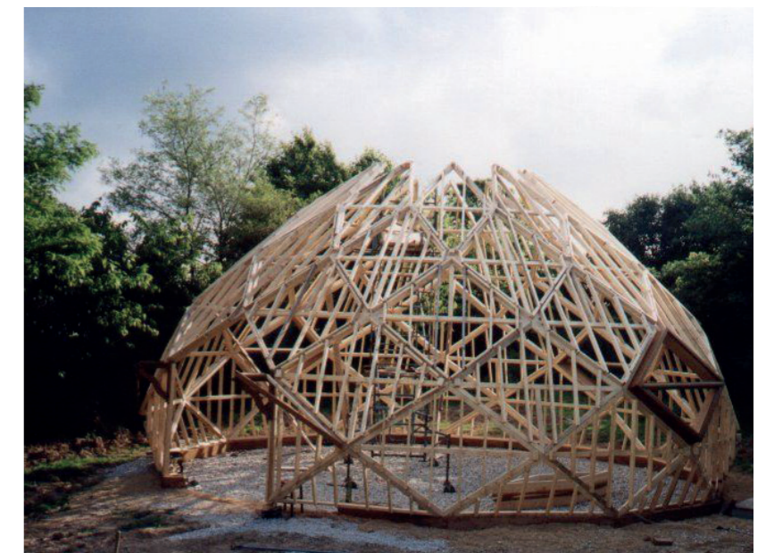
Charpente de maison
