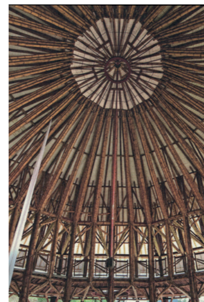
Charpente du ZERI vu de l'intérieur (Frey, 2013)
