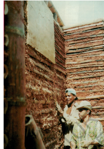
Construction d'une bareque en Colombie (Vitra 2000)
