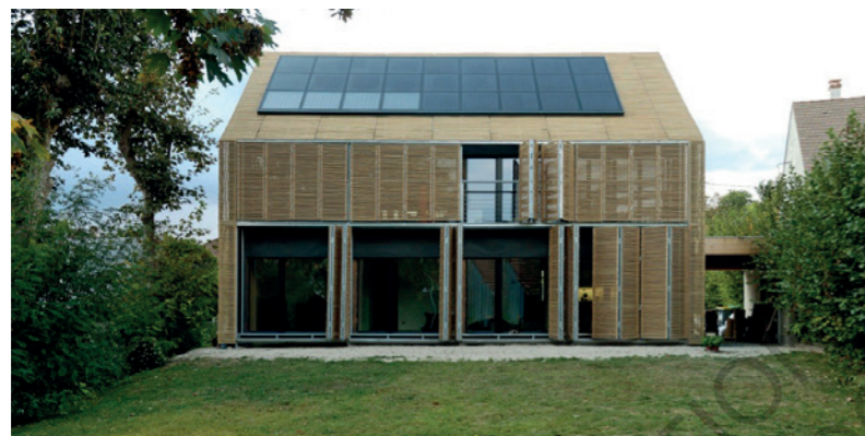
Principe d'ouverture/ fermeture de la façade de volets en bambou (archdaily)
