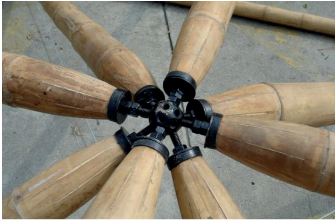
Technique d'assemblage s'inspirant du noeud MERO par Jörg Stamm (Minke, 2012)
