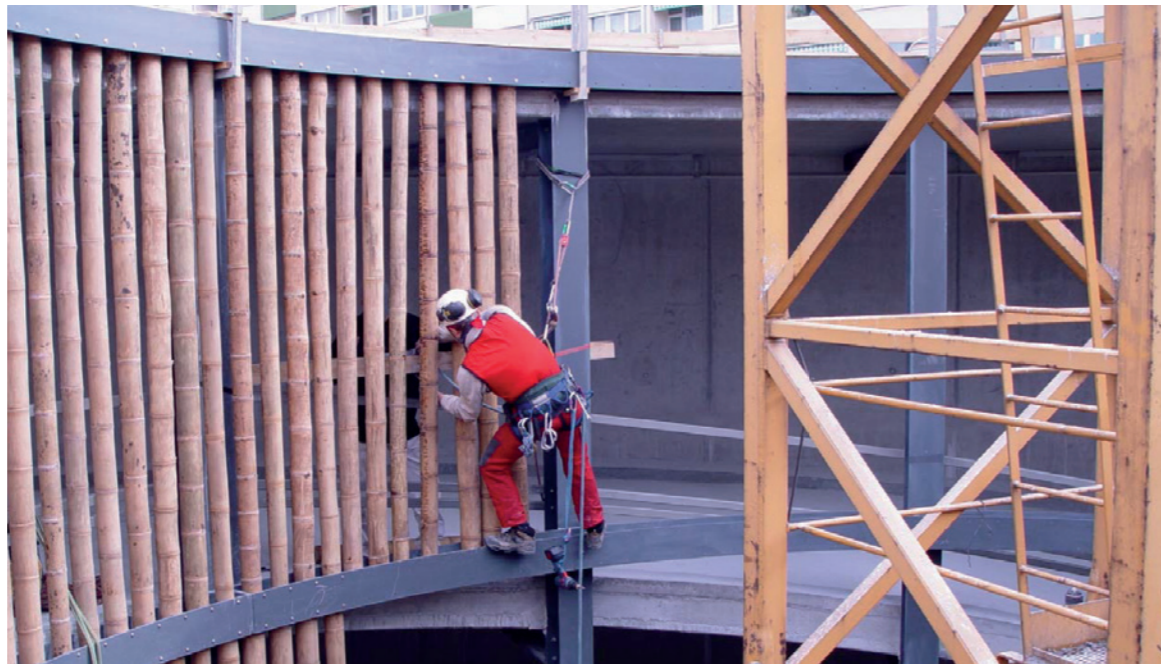
Mise en œuvre du Guadua Angustifolia en façade pour le projet du parking © HPP Architekten GmbH
