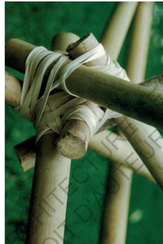
Assemblage via des lianes en caoutchouc (Vitra, 2000)
