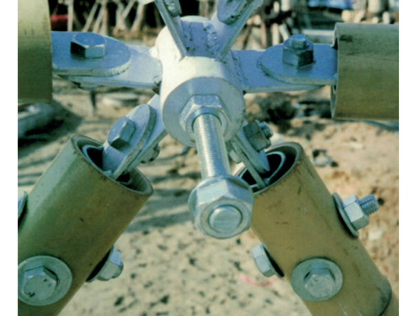
Technique d'assemblage par Shoei Yoh (Vitra, 2000)
