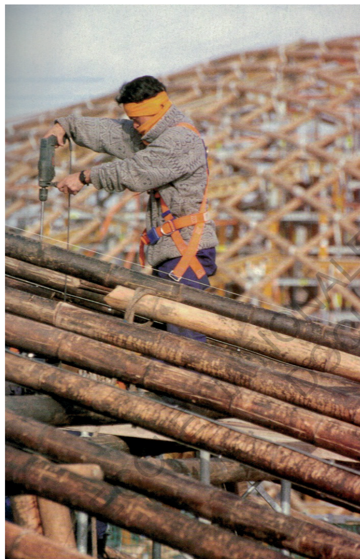
Ouvrier sur le toit du ZERI pavillon pour l'EXPO d'Hannovre (Vitra, 2000)
