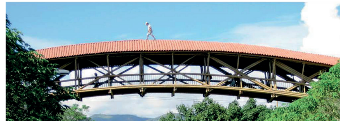
Pont piéton à Santa Fe de Antioquia en Colombie. Architecte: Jörg Stamm & Juan Carlos Sanz (Minke, 2012)
