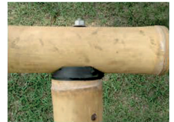
Technique d'assemblage par Adan Piza (Minke, 2012)
