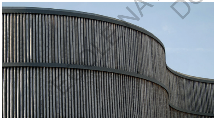
Détail de Façade du parking quelques années plus tard ©
