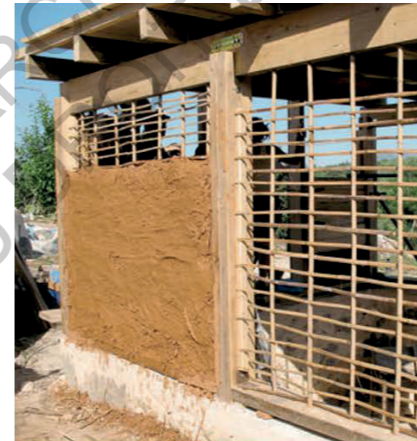
Construction d'un mur d'une pao a pique au Brésil (Minke 2012)
