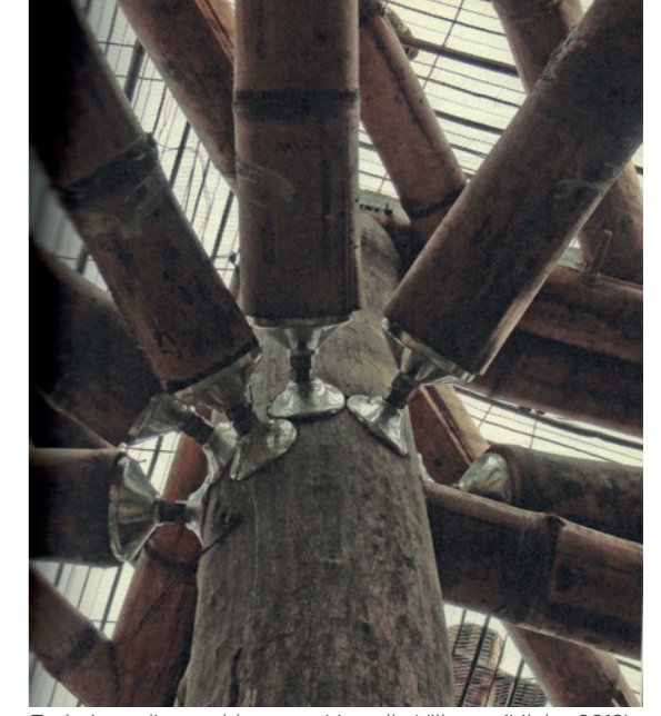
Technique d'assemblage par Marcello Villegas (Minke, 2012)
