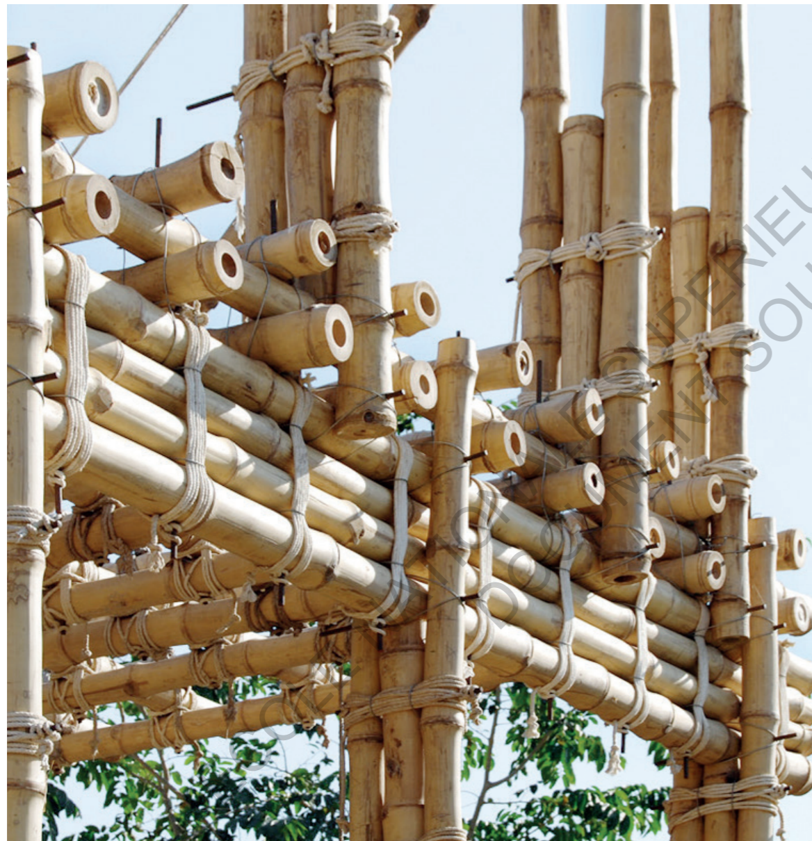
Détail de jointure au rattan d'une école dans la vallée du Punjab au Pakistan
