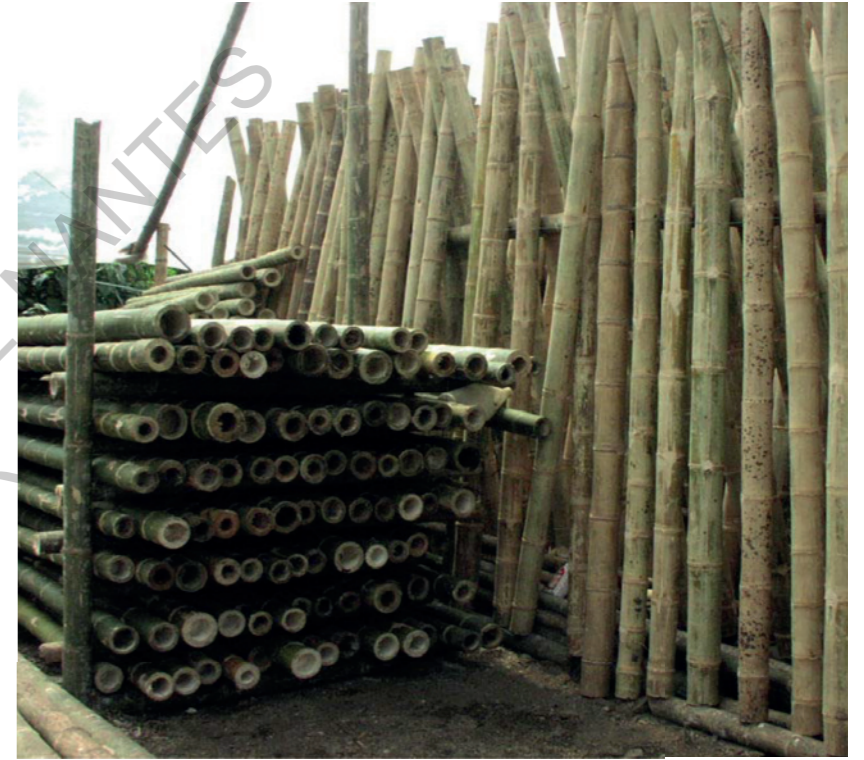
Etape de séchage de Guadua pour le parking de Leipzig © HPP Architekten GmbH
