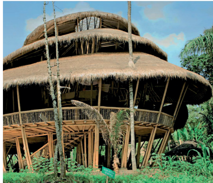
Green School à Sibajang Kaja Badung, en Indonésie. Architecte : Agence IBUKU - Aldo Landwehr & PT Bambu (Minke, 2012)
