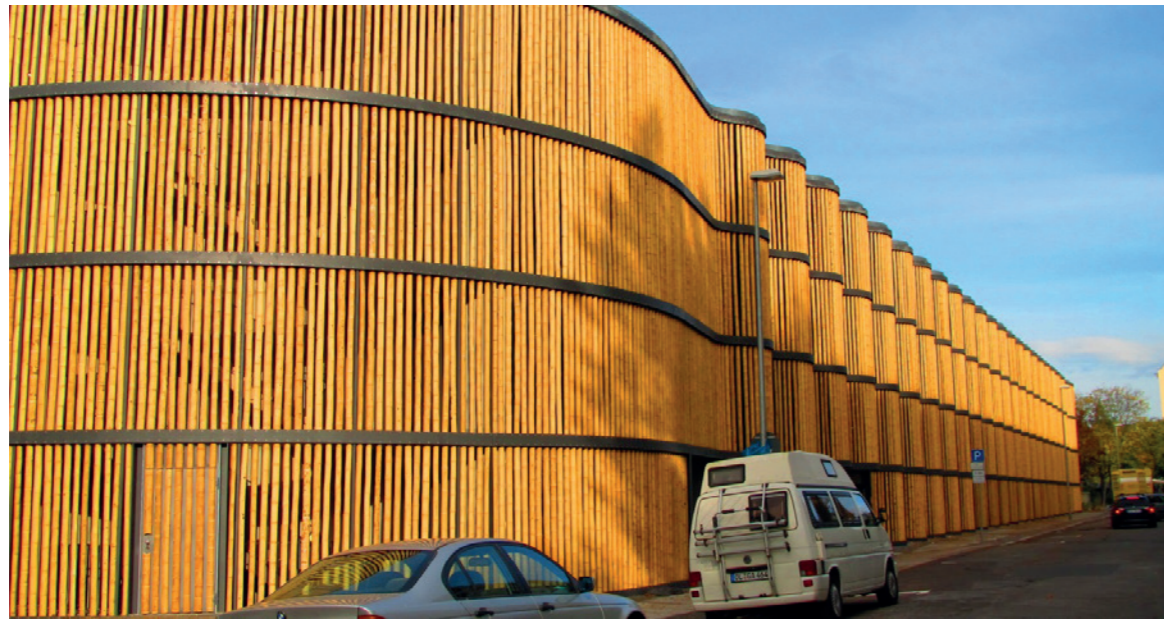
Façade du parking de 2012 au soleil couchant © Photographe de l'agence
