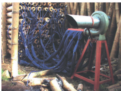
Pulvérisation d'air dans les chaumes, préalablement percés © HPP Architekten
