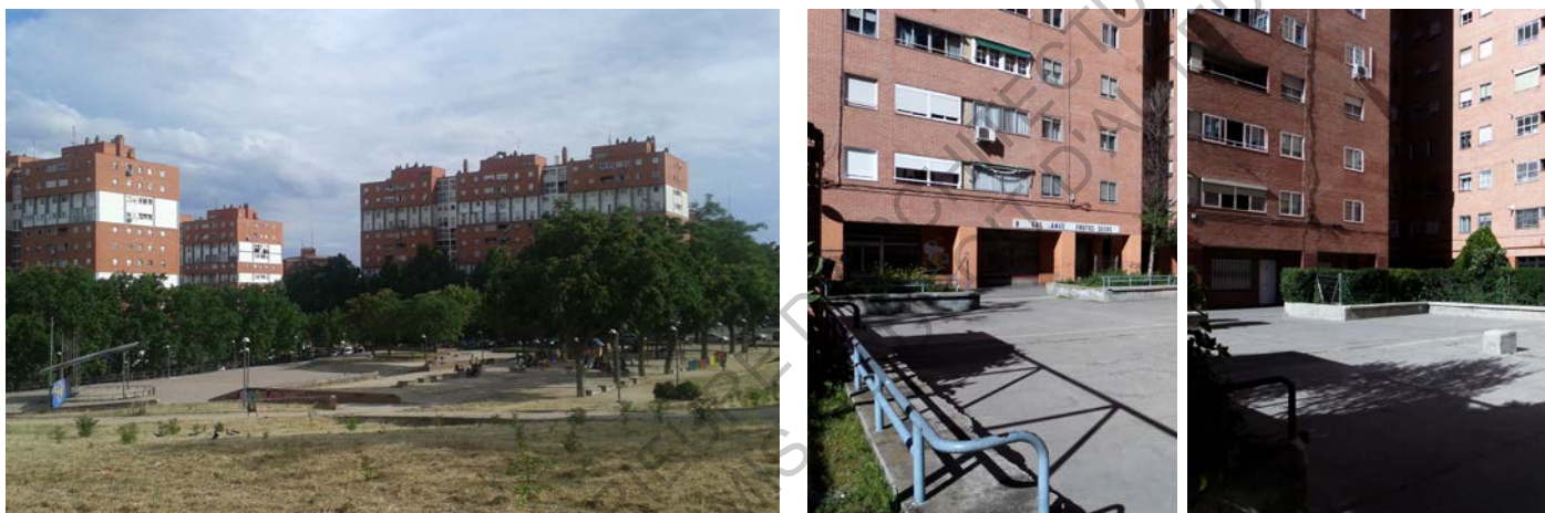
Figure 18 : A gauche le secteur réalisé par Junquera et Perez-Pita; à droite le secteur réalisé par Carvajal et Montes (photos montrant la différence d'entretien entre deux cours d'édifices)
