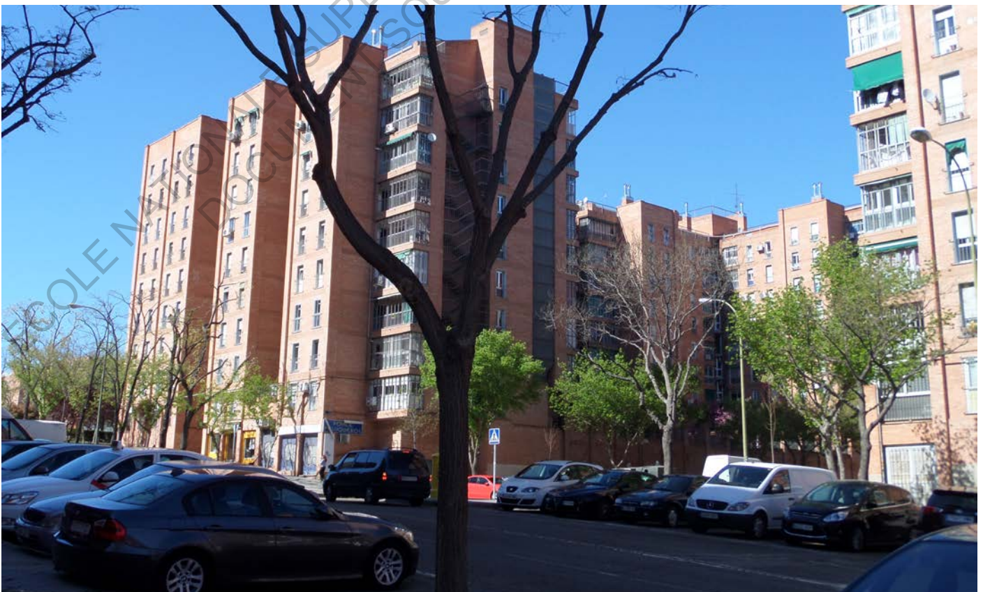
Figure 20 : Secteur 7 réalisé par Ferran et Navazo
