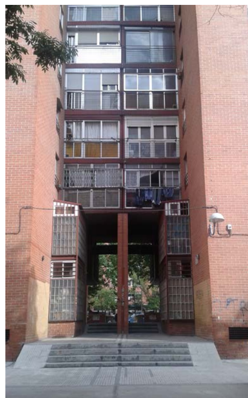
Figure 19 : (Ci-contre) Secteur 5 : Balcons reliant deux tours
