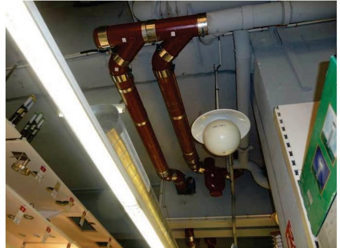
**Figure 17** : Canalisations en fonte changées au plafond de Leroy Merlin
