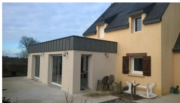
Figure 11: Exemple d'une extension, source http://www.construction-dorso.fr/extensions-5.html
