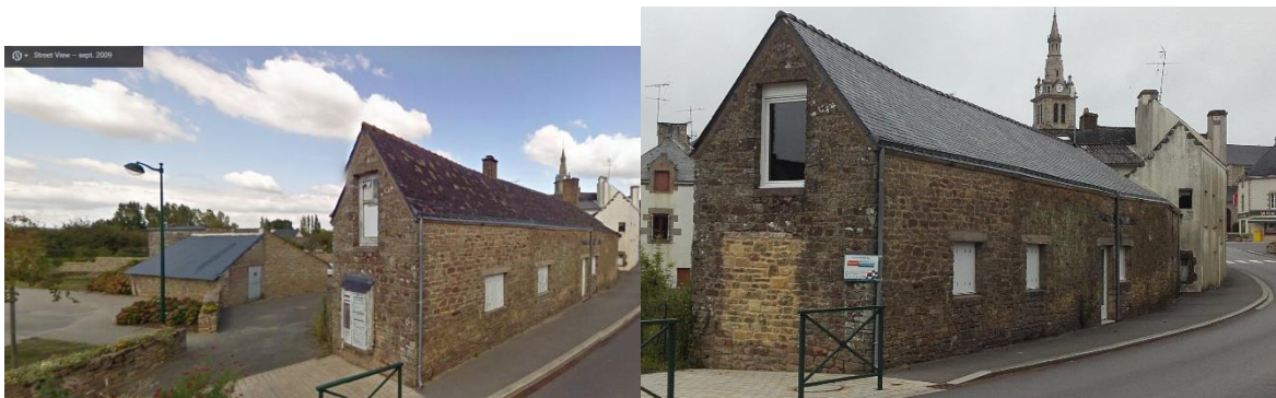
Figure 10: Exemple d'une rénovation, source à gauche google street view septembre 2009 à droite photographie personnelle mai 2017
