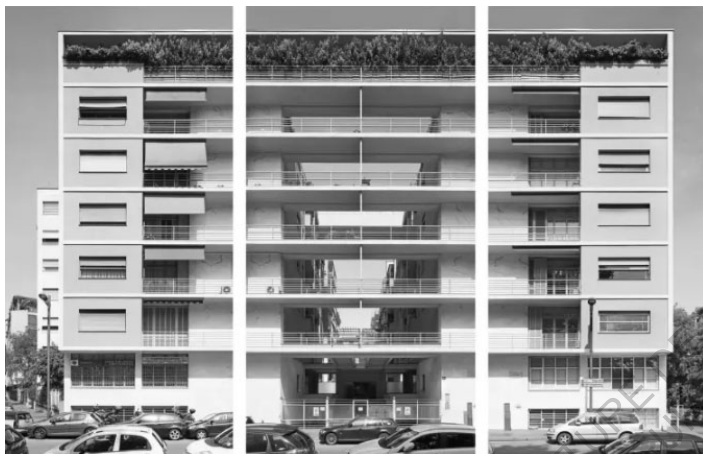
6. La casa Rustici de Terragni à Milan
