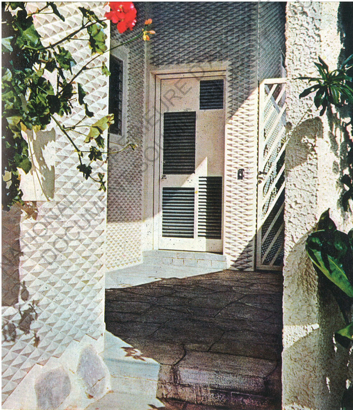
60. L'entrée de la Diamentina et sa façade en « diamants »
