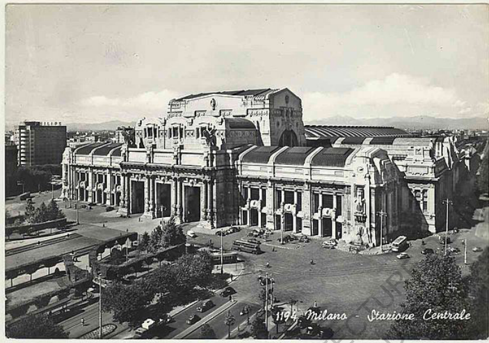
9. La Gare Centrale de Milan
