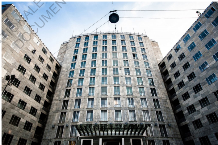
23. Le bâtiment central de la Montecatini, entourée de ses deux ailes latérales
