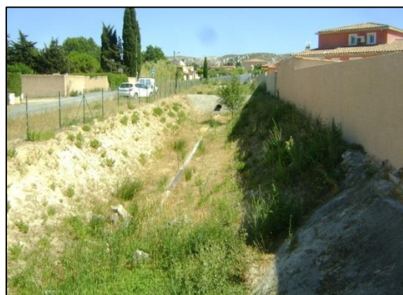
Figure 12. Photographie du bassin de rétention aval
