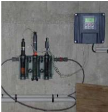
Figure 14 : Analyseur chlore et pH
