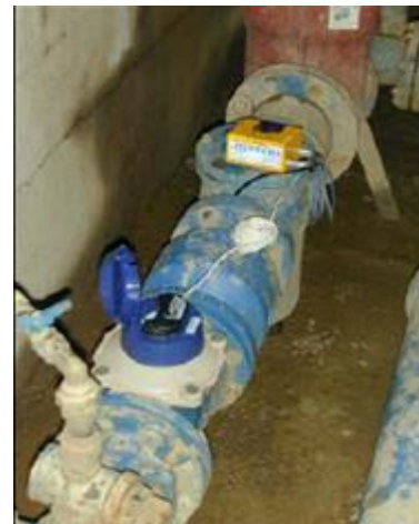
Compteur équipé d'une tête émettrice
