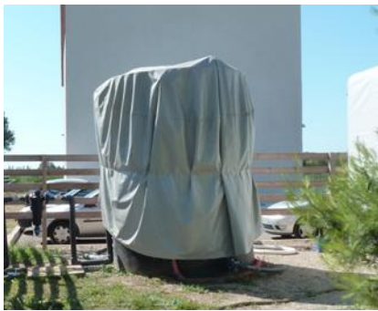
Stockage d'eau traitée clarifiée
