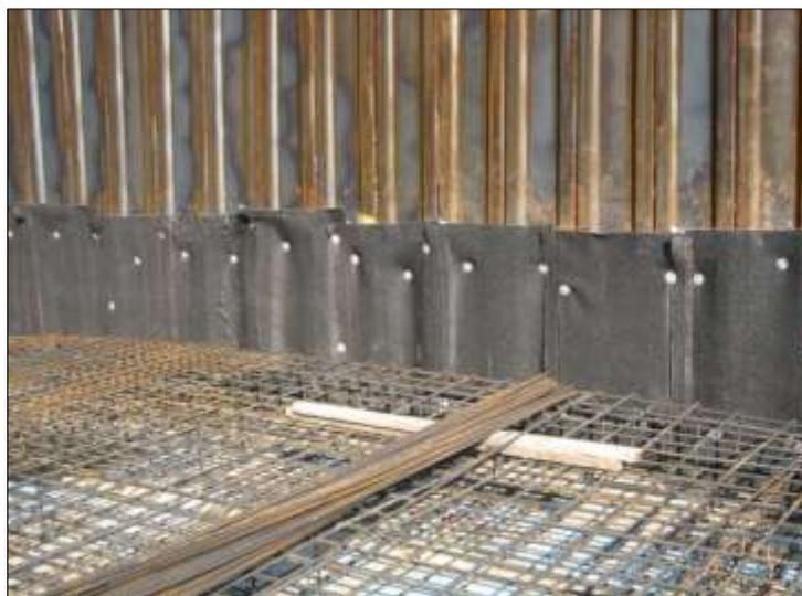
**Figure III-2 : Soutènement par rideaux de palplanches**
