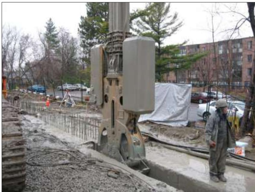
**Figure III-1 : Soutènement par paroi moulée**
