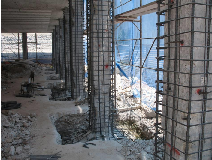
Figure 2- 7 : mise en place des armatures de renforcement.
