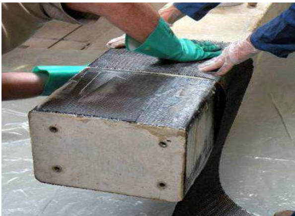
Figure 2- 16 : Chemisage d'un poteau par PRFC.
