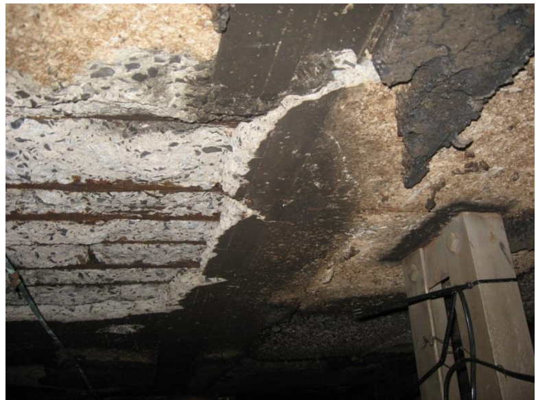
Figure 1-4 : Eclatement de l'enrobage. ("Prospec-plus")
