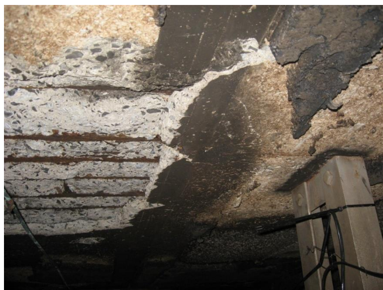
Figure 1-4 : Eclatement de l'enrobage. ("Prospec-plus")
