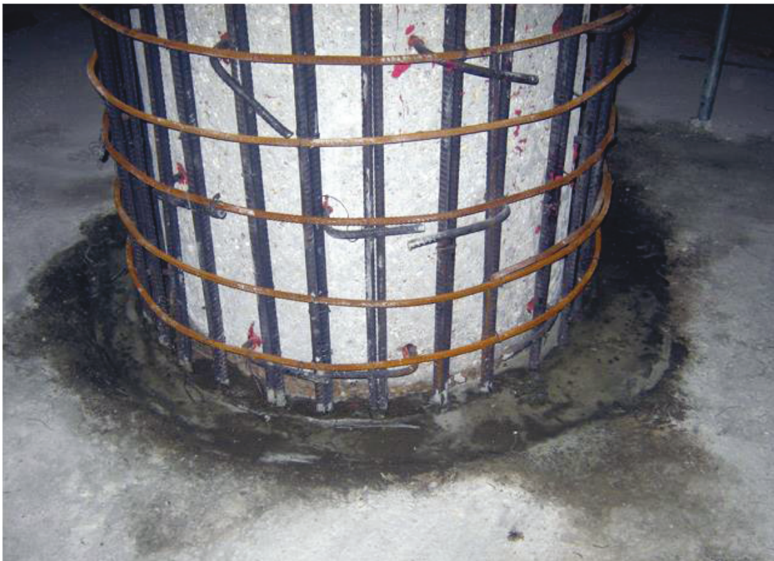
Figure 2- 6: chemisage en béton armé.
