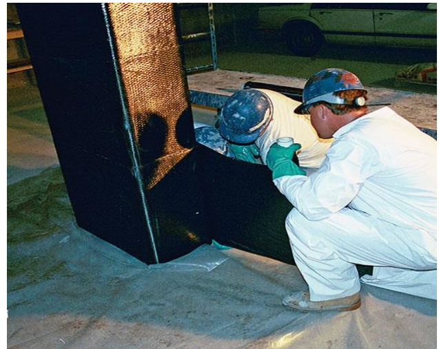
Figure 3-5 : Stratification en contact des colonnes (A et B)
