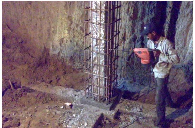
Figure 2- 8: Augmentation de la rugosité du poteau.
