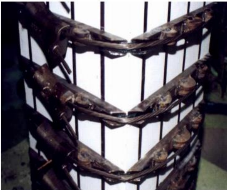
Figure 2- 14: Renforcement d'un poteau carré.
