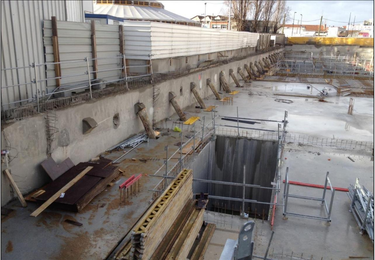
Figure 44—Aperçu des réservations prévues dans dalle pour les butons, chantier MARCHE VICTOR HUGO, Aubervilliers (93 300)
