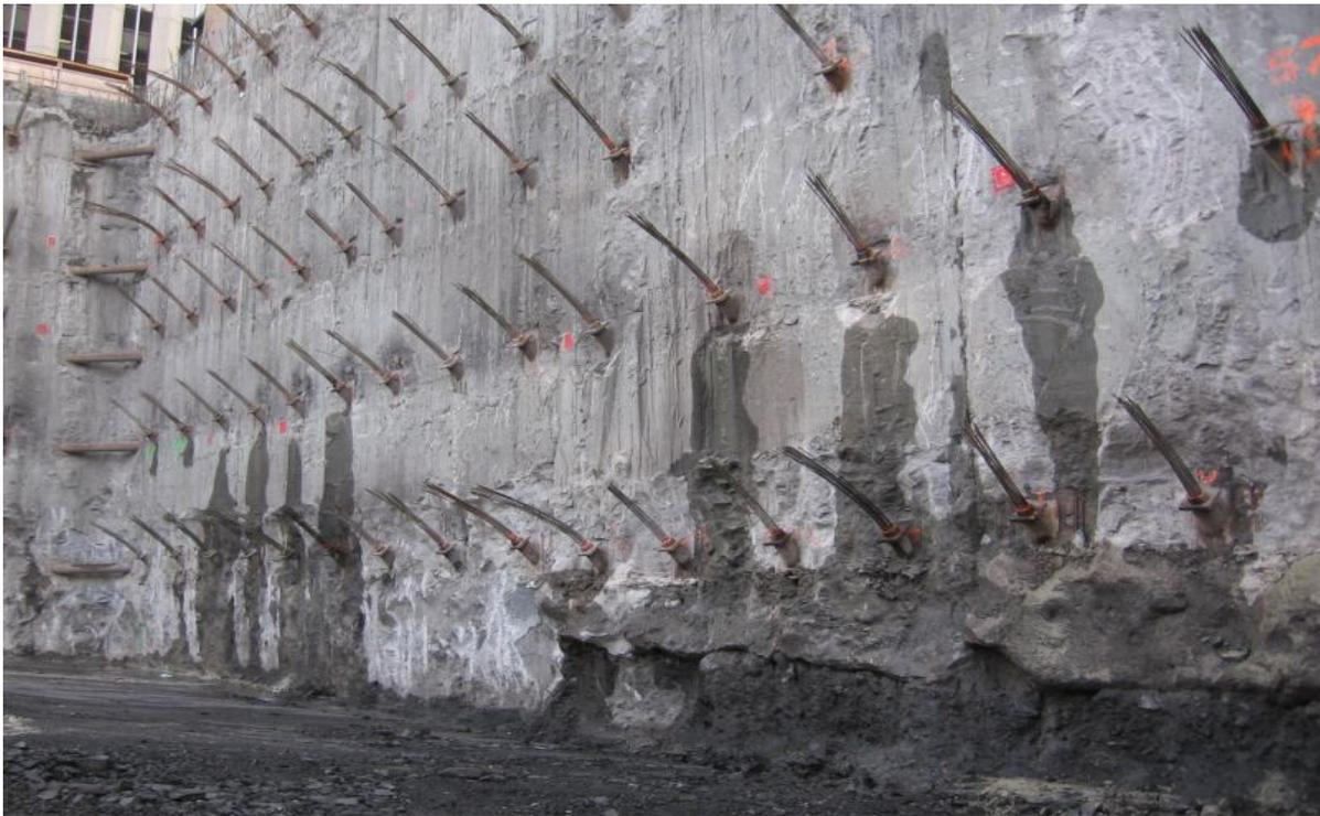
Figure 38 – Ecran de soutènement par paroi moulée tirantée
