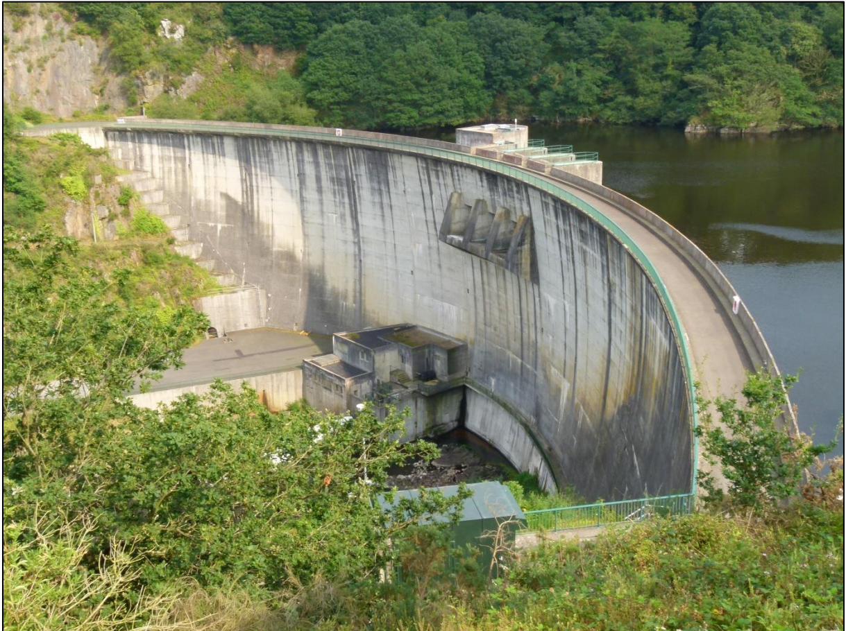
Figure 9: Vue sur le parement aval et le couronnement du barrage de Saint-Barthélemy
