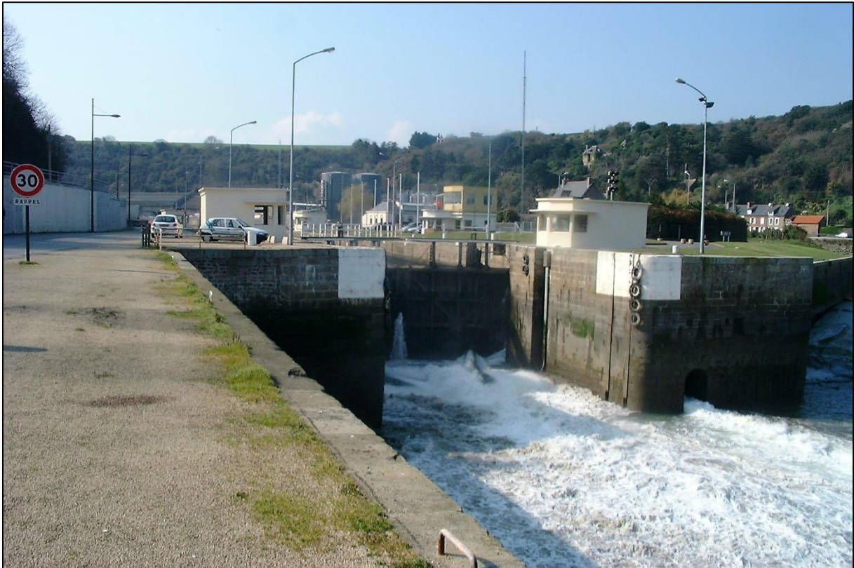
Figure 4: Vue sur l'écluse du port du Légué, dont les éclusages permettent le transit des poissons sur le Gouët
