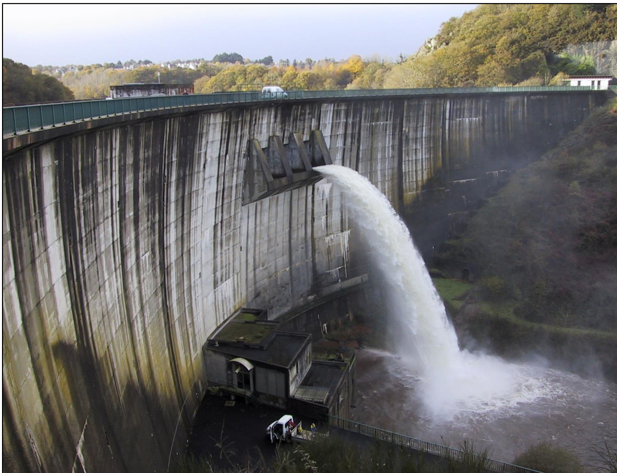
Figure 29: Débit sortant par un évacuateur de crue
