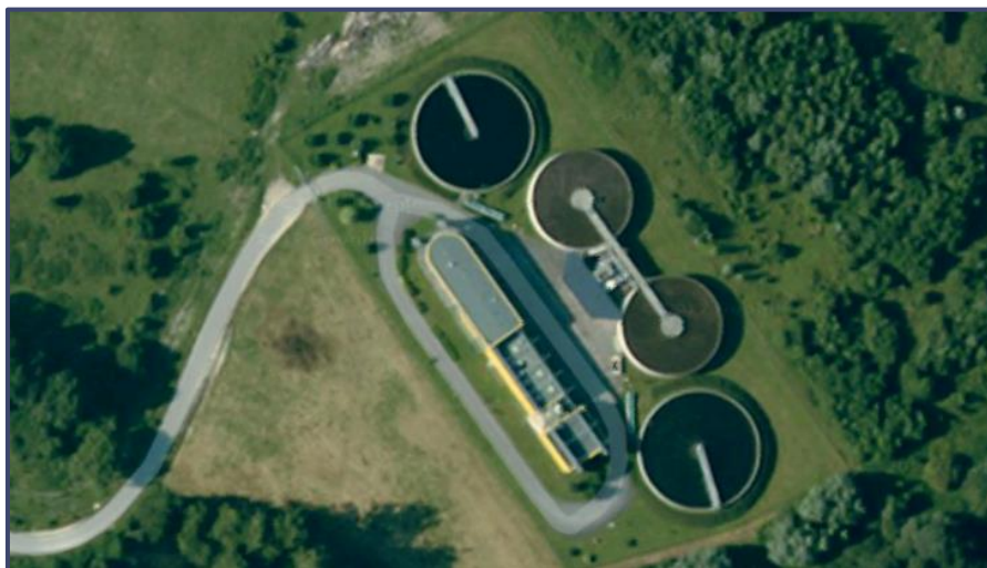
Figure 8 : Vue aérienne de la station d'épuration de la Héronnière (Source : GoogleEarth )
