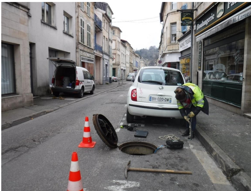
Figure 11 : Relève d'un point de mesure
