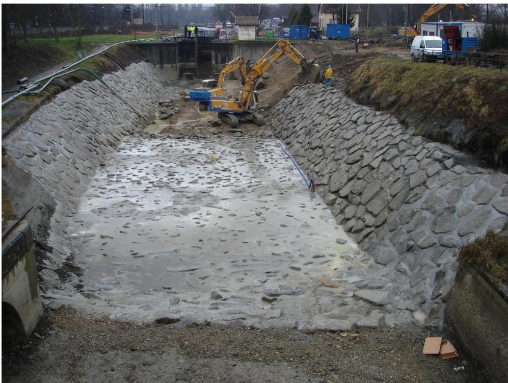
Figure 15 : renforcement du canal à l'aval de l'écluse 39
