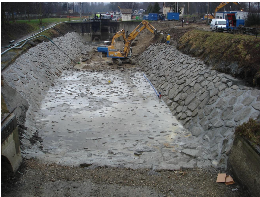
Figure 15 : renforcement du canal à l'aval de l'écluse 39
