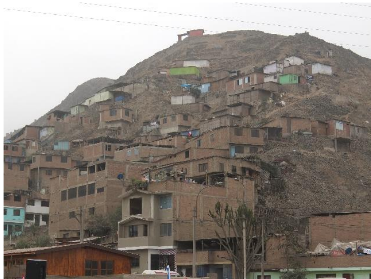
Photo 2 : Constructions sur zone accidentée, Lima, Villa María del Triunfo, 21/07/2017
