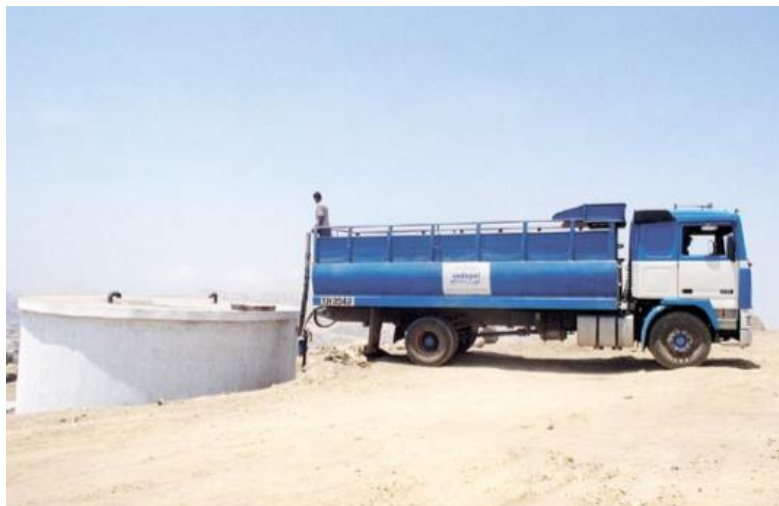
Photo 4 : Camion-citerne alimentant le réservoir d'un système progressif
