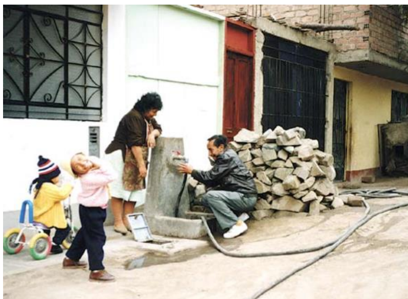
Photo 5 : Fontaine publique et tuyaux permettant de relier aux habitations
