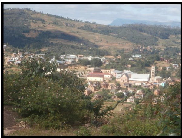
Figure 19: Vue du Chef-lieu de Mahasoabe depuis le futur réservoir de tête
