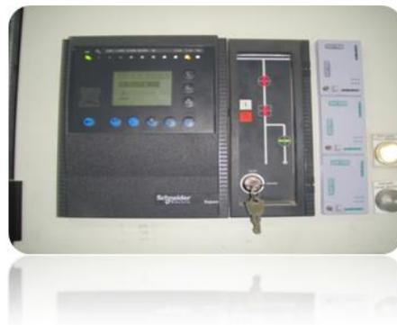
Figure 5: Exemple de relais numérique (SEPAM de Schneider Electric)
