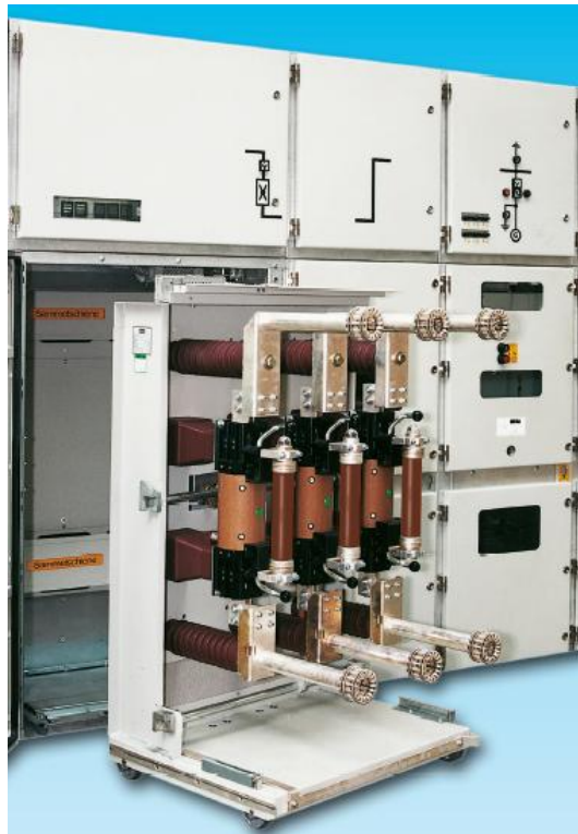
Figure 9: Système limiteur d'ABB. [13]
